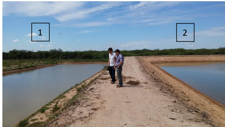
Fotografía 29. Tajamar pulmón (1) y reservorio tipo tajamar represa (2) Tte. 1ero Manuel Irala Fernández Reservorio (Intraversiones físicas demostrativas contra la desertificación y la sequía-IICA)
