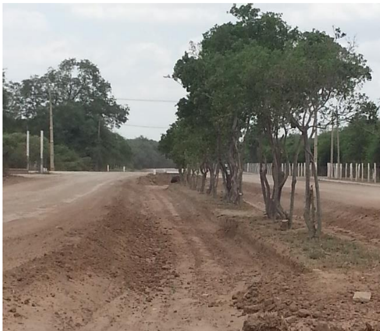
Fotografía 16. Mantenimiento en obras de colecta y transporte de agua Loma Plata
