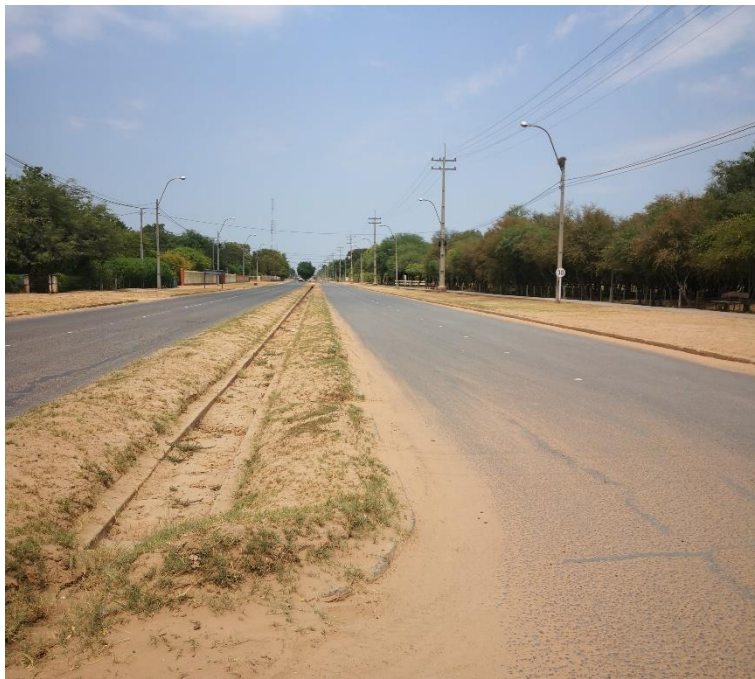
Fotografía 15. Acumulación de sedimentos en canales de conducción de agua, punto importante de mantenimiento del sistema (Filadelfia)
