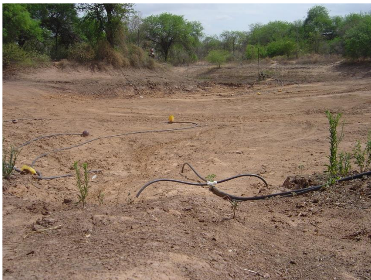
Fotografía 20. Pozos tipo bombilla con perforaciones múltiple en un tajamar de infiltración de agua
