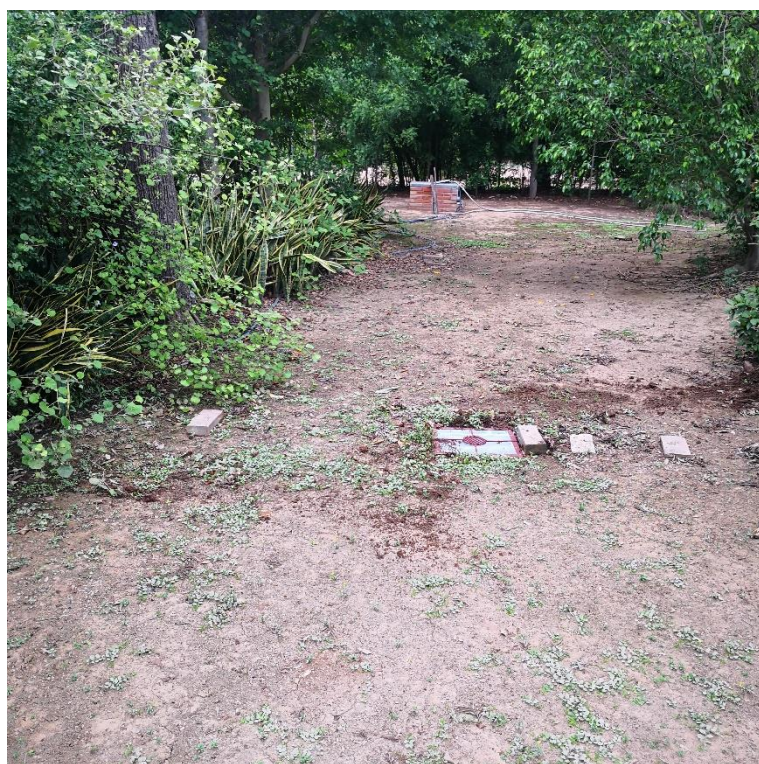
Fotografía 13. Patio domiciliario sistematizado para cosecha de agua. En primer plano alcantarilla de acopio de agua, en el plano de fondo aljibe para agua de patio
