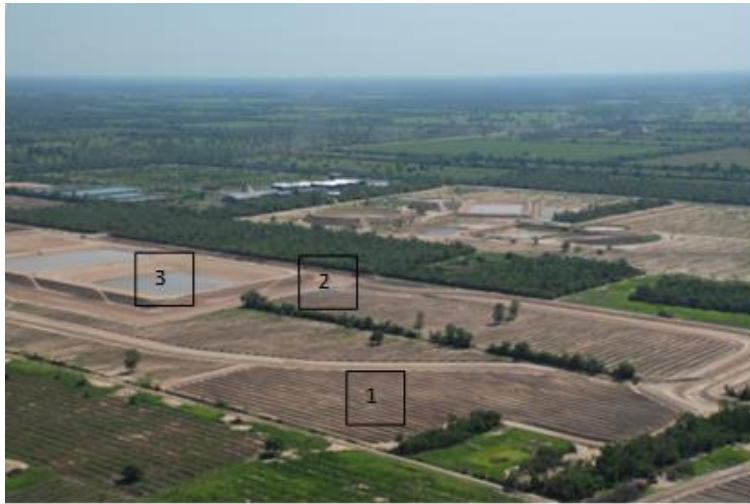
Fotografía 27. Complejo de captación y almacenamiento de agua de la Planta Frigorífica Loma Plata – Areas de captación 1, tajamar pulmon 2, reservorios tipo tajamar represa 3
