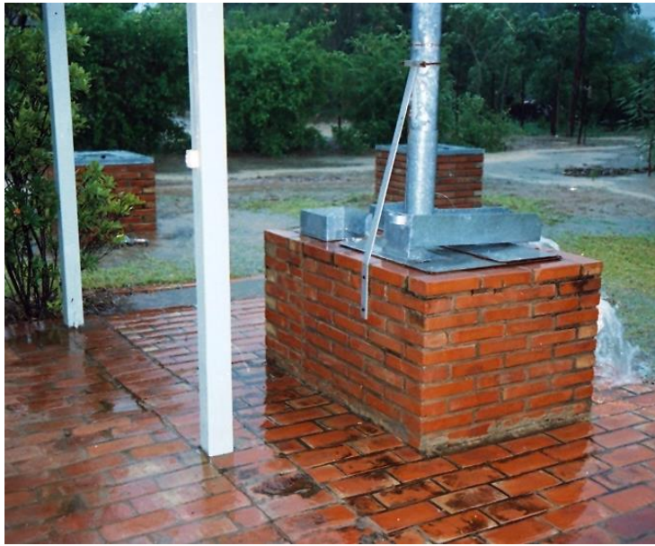
Fotografía 7. Canaletas con sistema de registro para administración de agua cosechada
