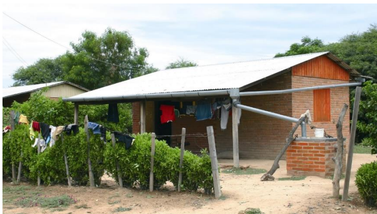
Fotografía 5. Vivienda con sistema de colecta y aljibe de características mínimas
