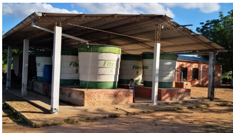
Fotografía 9. Exitoso sistema de colecta de agua y aljibes comunitarios Comunidad Betania (área de cosecha 250 m 2 área de cosecha, 30 m 3 de capacidad de reserva, > 20 años de uso)
