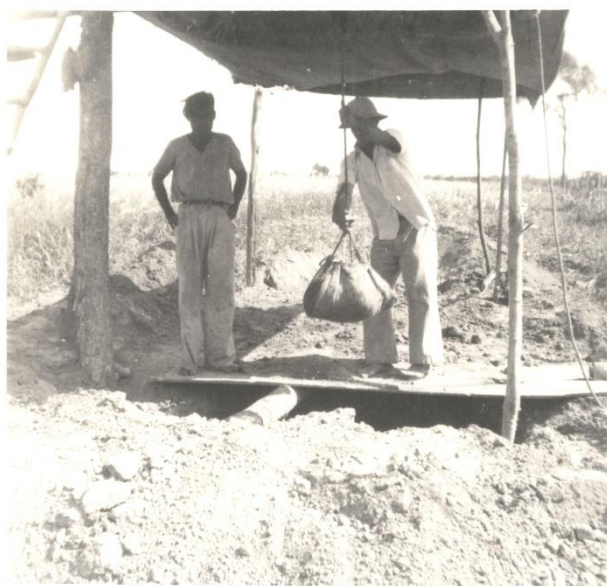
Fotografía 2. Excavación de pozo en el Chaco, Colonia Fernheim 1930
