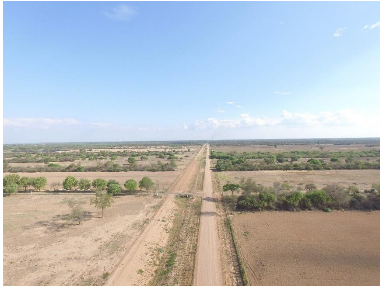
Fotografía 21. Muro y canal de deriva de agua de lluvia al oeste de la ciudad de Loma Plata
