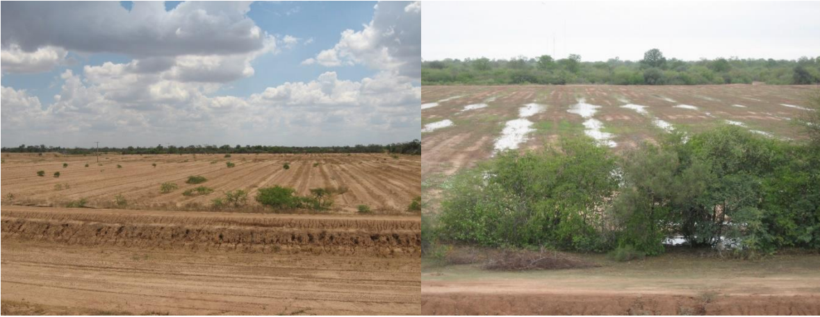
Fotografía 31. Fotografías de áreas sistematizadas de cosecha de agua con 2,5 años de uso (Izquierda construcción adecuada, derecha con errores construcción por la acumulación de agua en los canales)
