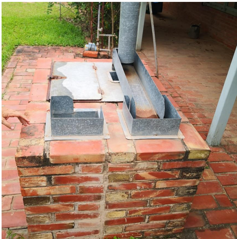
Fotografía 11. Punto de administración de agua de lluvia cosechada de techos domiciliarios
