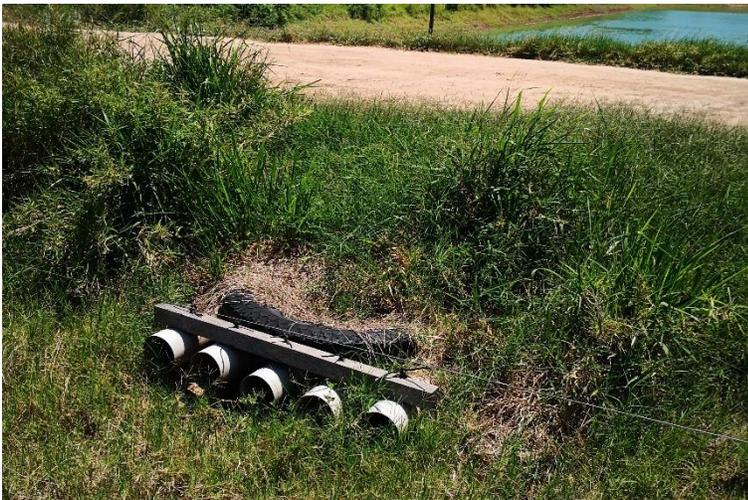
Fotografía 23. Alcantarillas de toma de agua en tajamares de sedimentación, diseñados para reducir introducción de sedimentos
