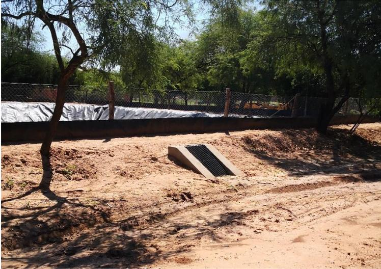
Fotografía 17. Reservorio impermeabilizado almacenamiento de agua de área de servicios (Neuland)
