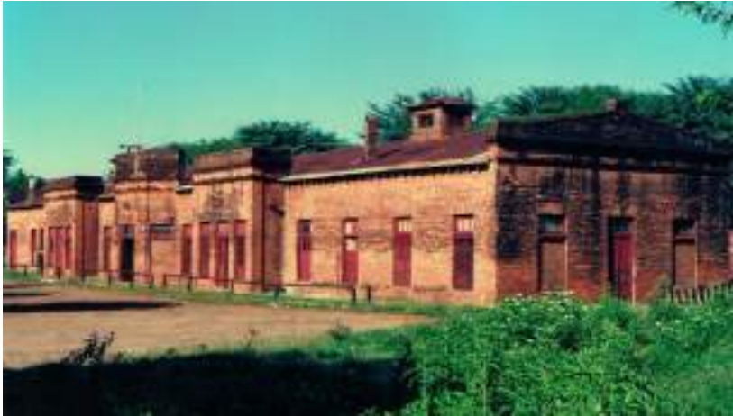
Figura 2. Antigua Estación de Ferrocarril de Encarnación
