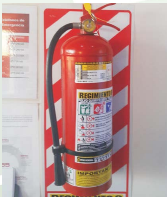
Figura 66. Los extintores deben estar disponibles para cualquier emergencia.
