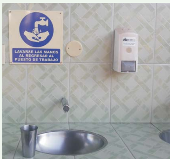
Figura 64. Instalación de lavamanos en las cercanías de la planchada del secadero.
